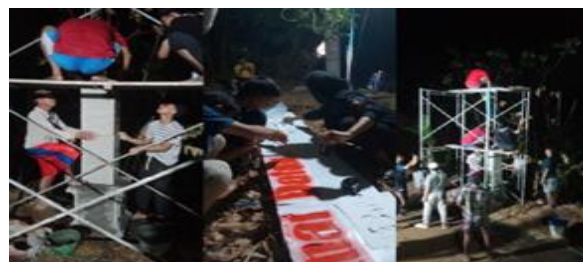
Gambar 2. Pembuatan gapura yang sebagian bahannya dari bamboo.
