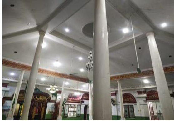
Gambar 3. Soko guru/Tiang penyangga
